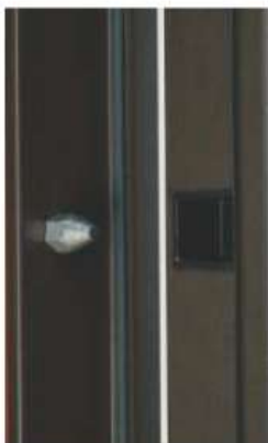
Shul me hapje të limituar Manual Hook Limiter
